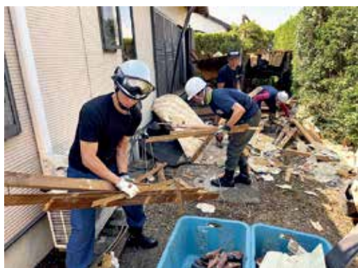
破損した家屋や瓦、ガラスの破片等の運び出し
