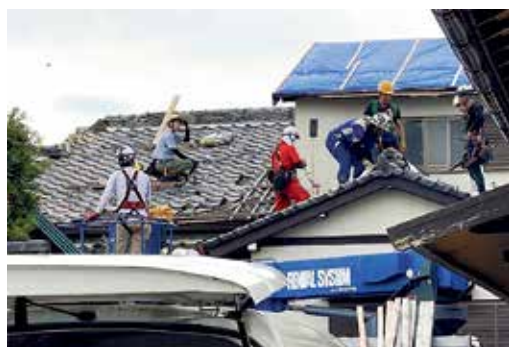
屋根の応急修理
