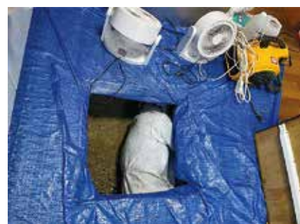
浸水被害に対する床下の乾燥作業
